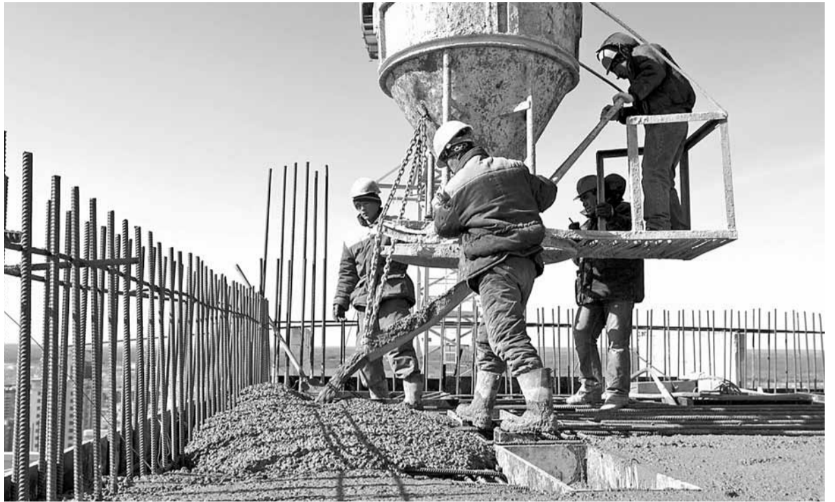
Строительство - самая травмоопасная сфера в Татарстане.
